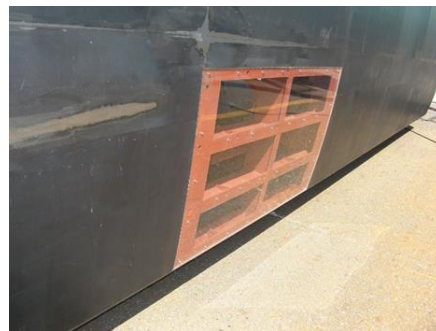
図2 透明型枠
