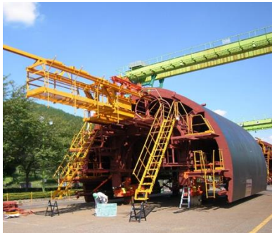
図1 セントル (トンネルの型枠)
